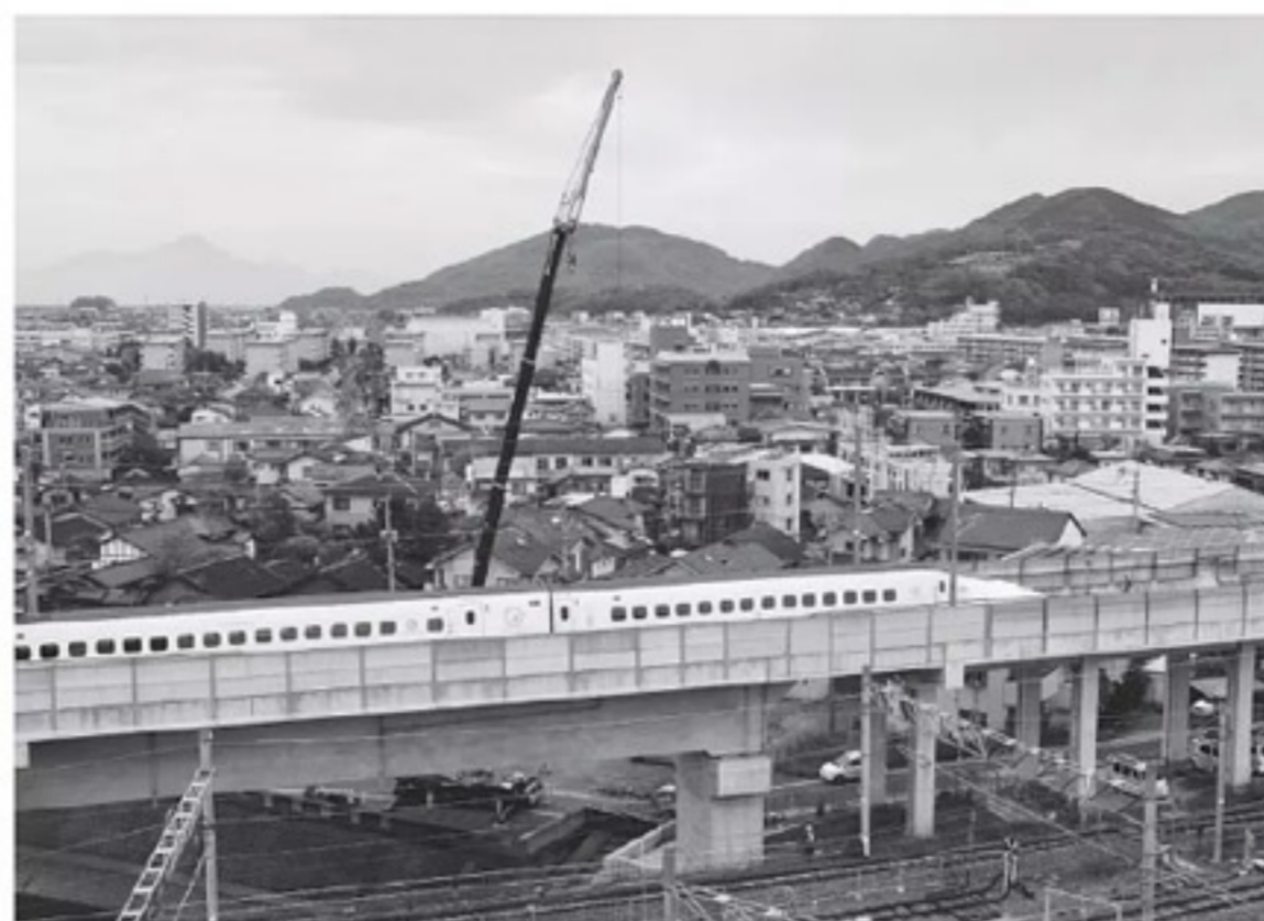
今回の地震では九州新幹線も脱線した。防音壁などに亀裂が入ったといひ、大地震へのもろさを露呈してしまった。高架の細い橋脚が震度7で折れなかったのが幸いだ
