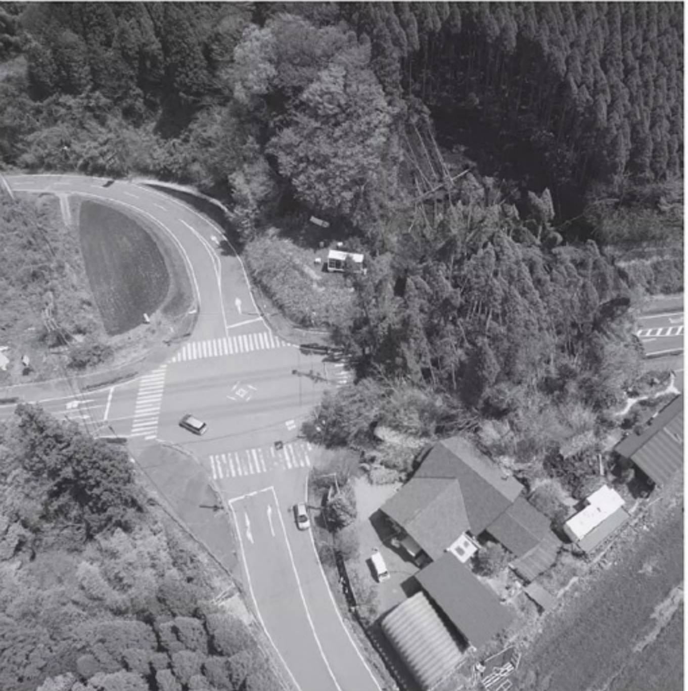
本文中に出てくる南阿蘇村河陽地区の土砂崩れ現場。十字路がT字路になり、家が土砂に埋まる寸前だった(ドローンで撮影)
